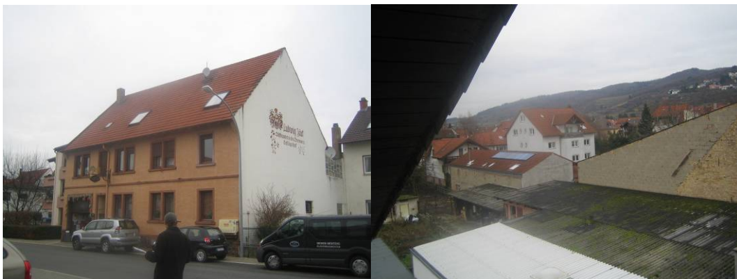
Abb. 4: Ladenburger Straße 14; Blick in den Blockinnenbereich
